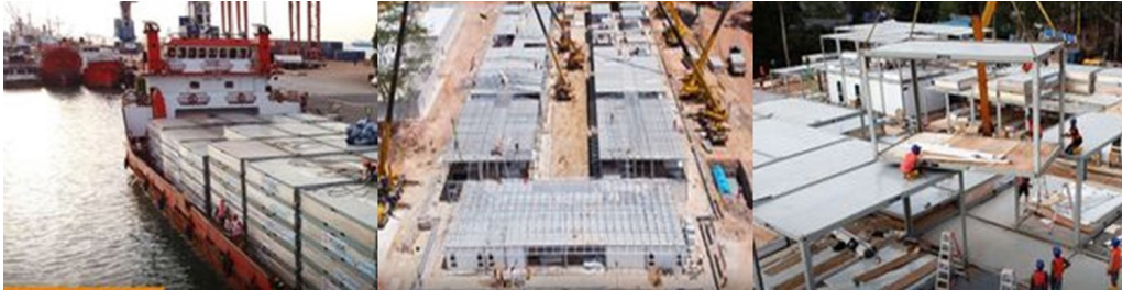
Gambar 4.9 Penerapan Modular Construction oleh WIKA Gedung (sumber: https://www.wikagedung.co.id/dev/industri_166/modular.html )
