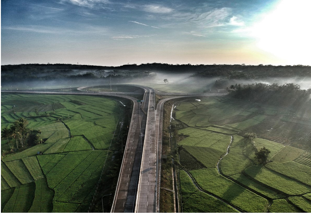
Gambar 4.1 Pembangunan Infrastruktur Jalan Raya (sumber: koleksi lomba foto LPJK)
